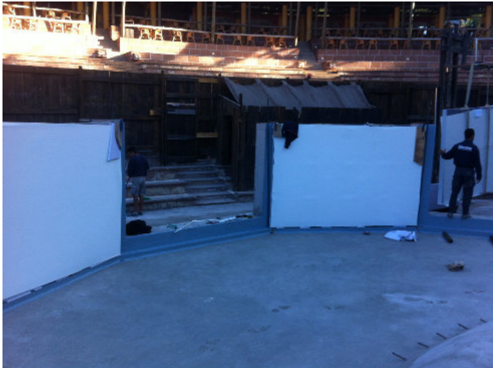
Instalación de 7 paneles de metacrilato para el show de leones marinos de Jungle Park. Tenerife
