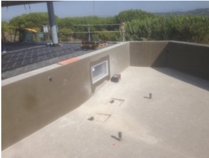
Instalacion en Sotogrande
